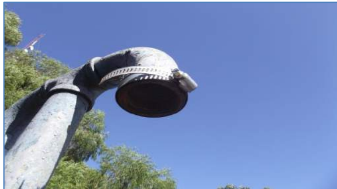
Imagem 50: Tela de proteção no duto de ventilação.
