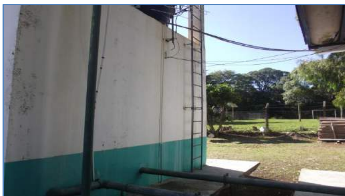
Imagem 45: Escada de acesso.
