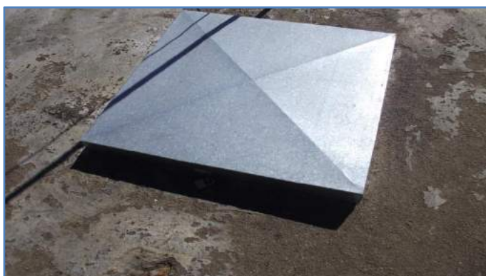
Imagem 47: Tampa de inspeção.
