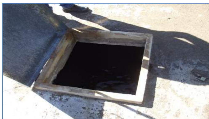
Imagem 48: Tampa de inspeção.
