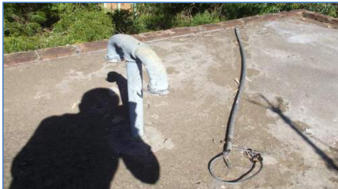
Imagem 49: Dutos de ventilação.
